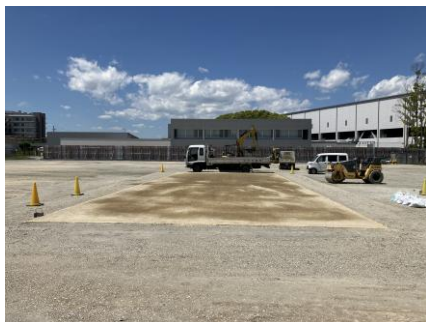
【整備】地鎮祭エリア・場内の整地および重機作業
