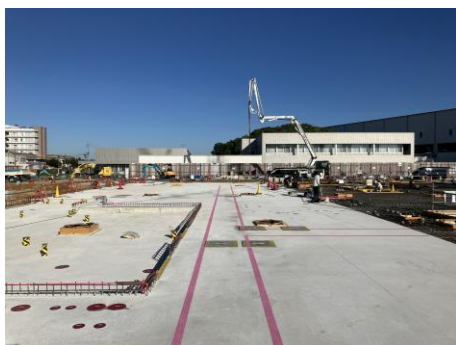
1F1 工区ライン、2 工区 CON 打設
