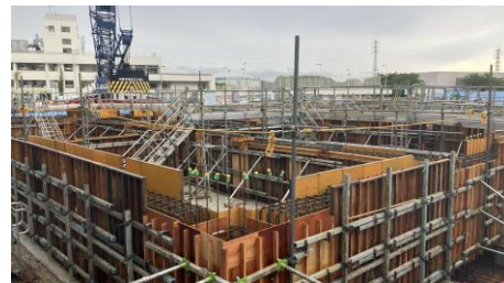
【5 工区】基礎梁打設前の型枠・配筋状況
