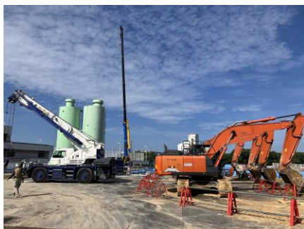
【プラント】浅層改良完了およびプラント 解体状況
