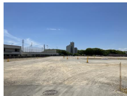
【地盤】場内の砕石敷きおよび整地・転圧作業
