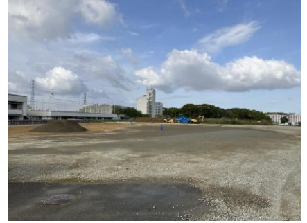
敷地全体の地盤整備・整地作業の様子
