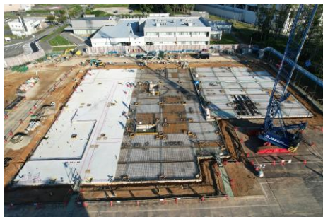
【全景】1Fスラブ完了・地上準備（ドローン撮影）
