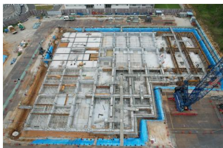
【全景】9 月上旬 上空からの全景
