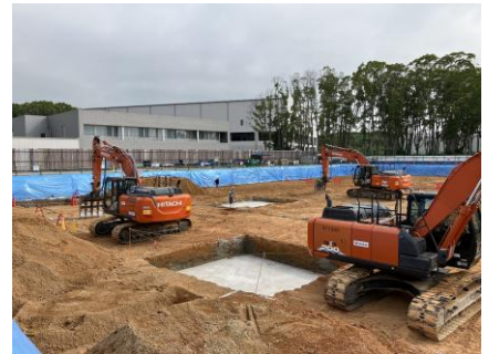
【地盤】重機による浅層地盤の改良施工状況
