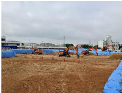
【地盤】敷地全域における掘削・地盤改良作業
