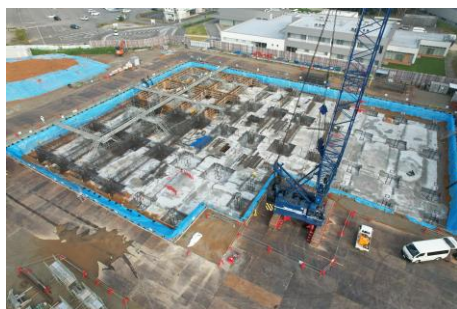
【全景】基礎躯体工事進捗のドローン全景
