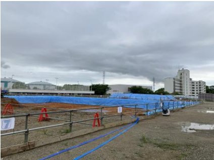
【敷地全景】掘削着手・仮囲いおよび法面保護状況
