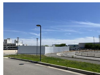
【仮設】敷地西側における仮囲い設置状況
