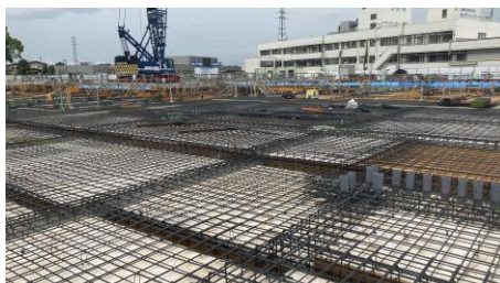
【1F 床】1 階スラブ配筋の施工状況
