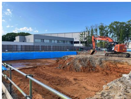
【掘削】初期根切り・土砂掘削作業の様子
