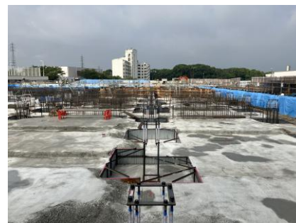
【5工区】ハイベース設置および 基礎配筋状況
