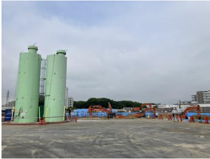
【プラント】浅層改良用プラントおよびサイロ設置状況
