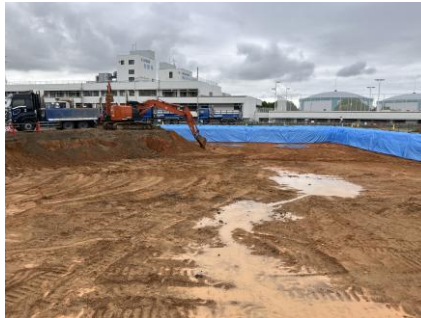
【掘削】重機による土砂搬出・根切り作業
