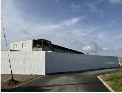
仮設事務所および外周仮囲いの設置状況
