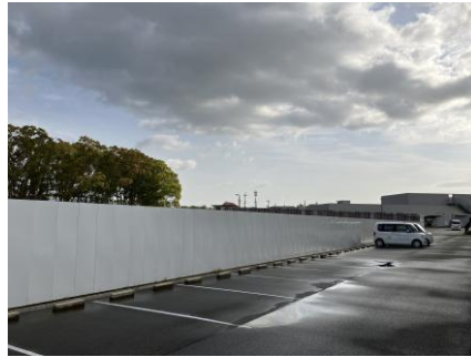
現場南側における仮囲いパネル設置状況
