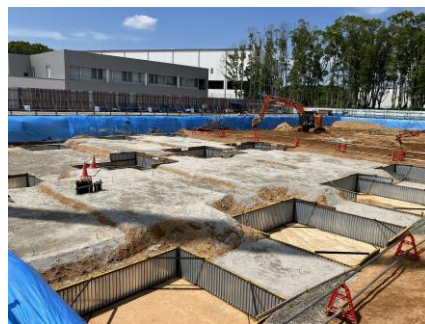
【基礎】基礎床付け後の砕石敷き状況
