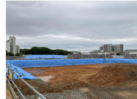
【全景】掘削完了エリアの法面シート養生状況
