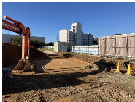
受水槽基礎下地盤改良
