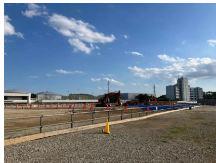
【全景】敷地全体の掘削工事全景
