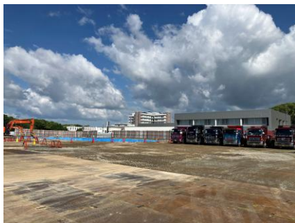
【搬出】ダンプトラック待機・掘削土搬出準備状況
