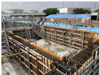
【1工区】基礎躯体の型枠組立状況
